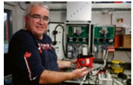
Bruno Schranz mit einem Signalfeuer, das die Swisscom in ihren Sendeanlagen einsetzt und das von einem PFC100-Controller gesteuert und überwacht wird.
