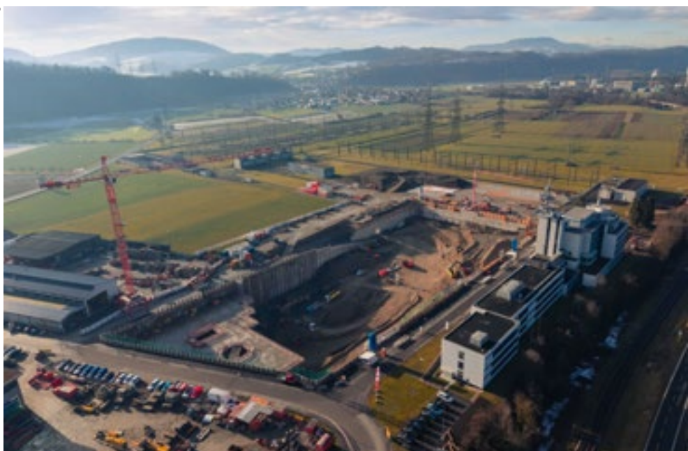
Flex-Base, le plus grand système de stockage par batterie du monde , est en cours de construction à Laufenburg. Il s'agit d'un système de stockage par batterie d'une puissance de 1200 MW et d'une capacité de 2100 MWh, qui utilisera la technologie redox-flow. L'achèvement est prévu pour 2028. La photo montre le chantier immense et l'étoile de Laufenburg en janvier 2026.
