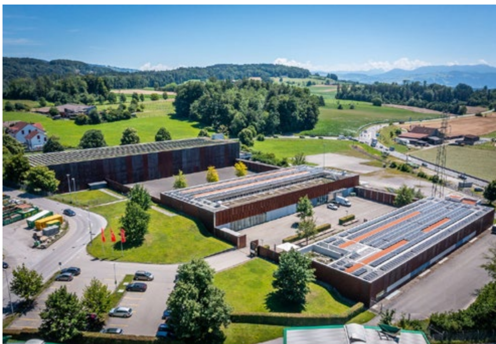
L'année 2024 marque le point culminant du développement solaire en Suisse jusqu'ici. Avec 1,8 GW de puissance nouvellement installée, un autre record a été établi.
