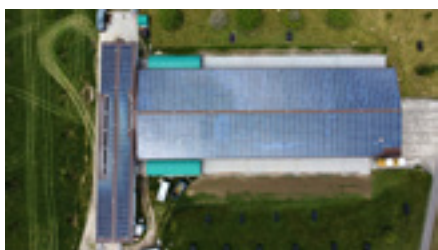
Vue aérienne de l'une des grandes installations solaires du Sagihof.
